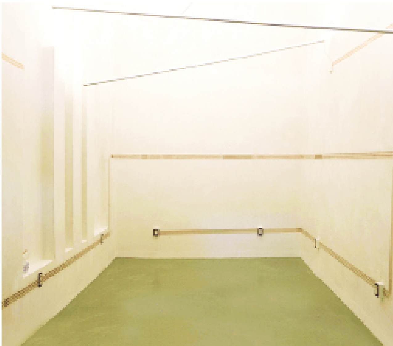
Esempio: Impianto Next-Tape applicato a "Sotto il Salone" presso il Palazzo della Ragione di Padova (edificio del 1200 ca.)
