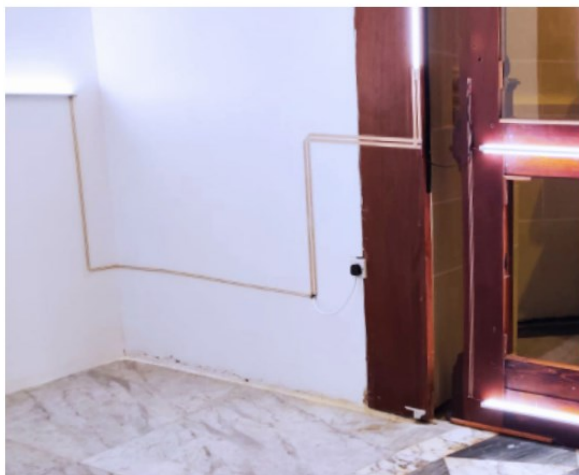
Figura 20: Realizzazione di un impianto di illuminazione di una statua posta in una nicchia della chiesa con i Nastri elettrici NM2BT05 e NM2BT15 e i led Next-Light
