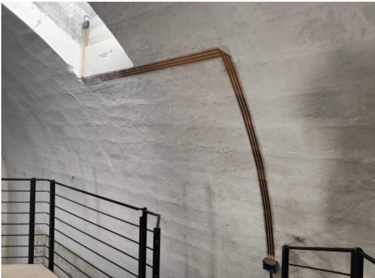
Figura 26: Realizzazione dell'impianto di elettrificazione di un lucernaio con Next-Tape NM3BT15 per un ambiente coperto da volta a Matera
