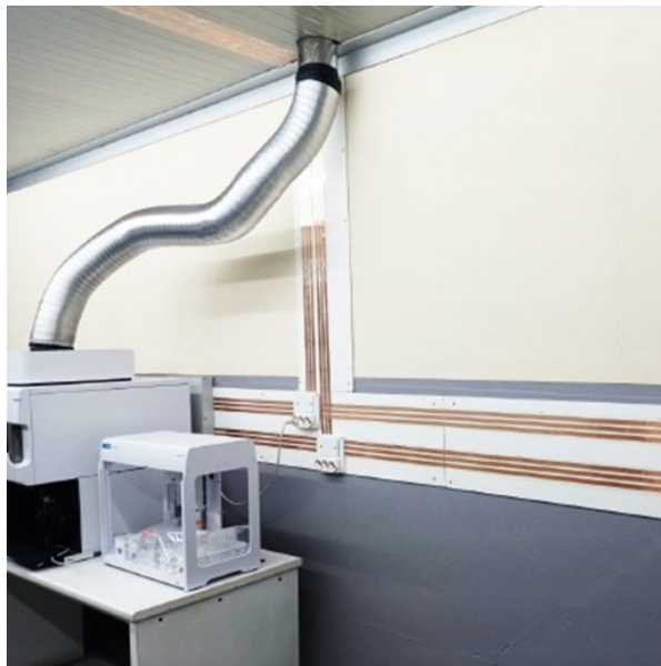
Figura 9: Esempio di adattabilità del nastro negli ambienti a maggior rischio di incendio
