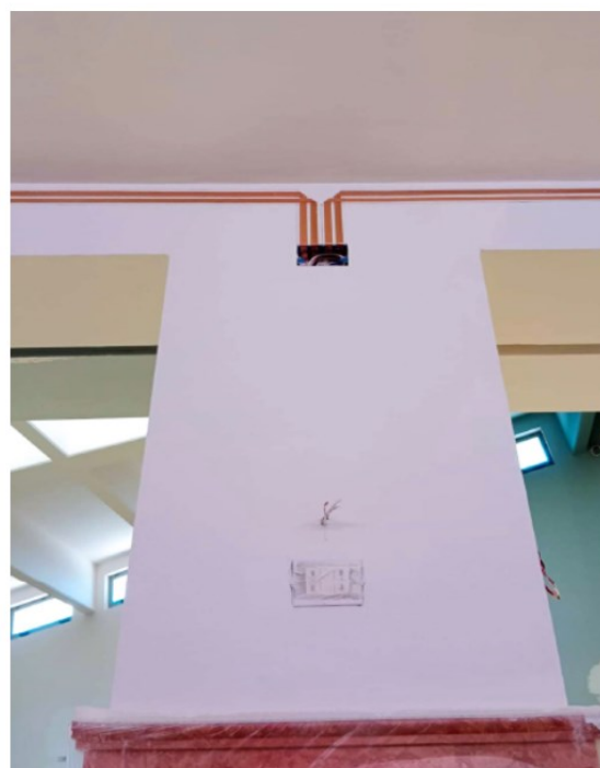
Figura 24: Realizzazione di un impianto di illuminazione mediante Nastro elettrico NM3BT15 in una chiesa di Andria, in Puglia
