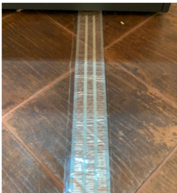
Figura 19: Realizzazione linea alimentazione per teche in vetro, mediante Nastro elettrico NM2BTF15 con posa a pavimento
