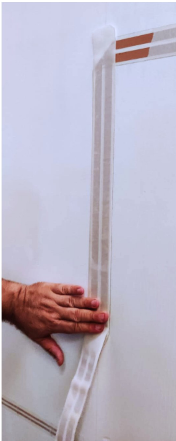
Figura 21: Realizzazione di un impianto di illuminazione di una statua posta in una nicchia della chiesa con i Nastri elettrici NM2BT05 e NM2BT15 e i led Next-Light
