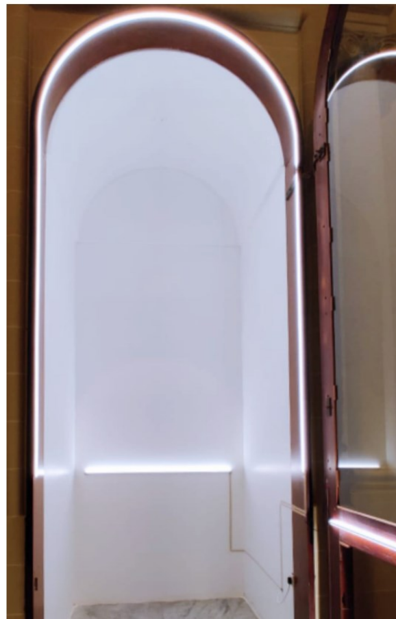
Figura 20: Realizzazione di un impianto di illuminazione di una statua posta in una nicchia della chiesa con i Nastri elettrici NM2BT05 e NM2BT15 e i led Next-Light
