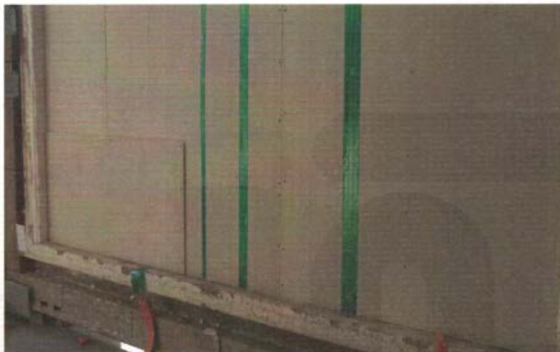
Foto 1: Applicazione nastri conduttori tra i due strati di lastre
