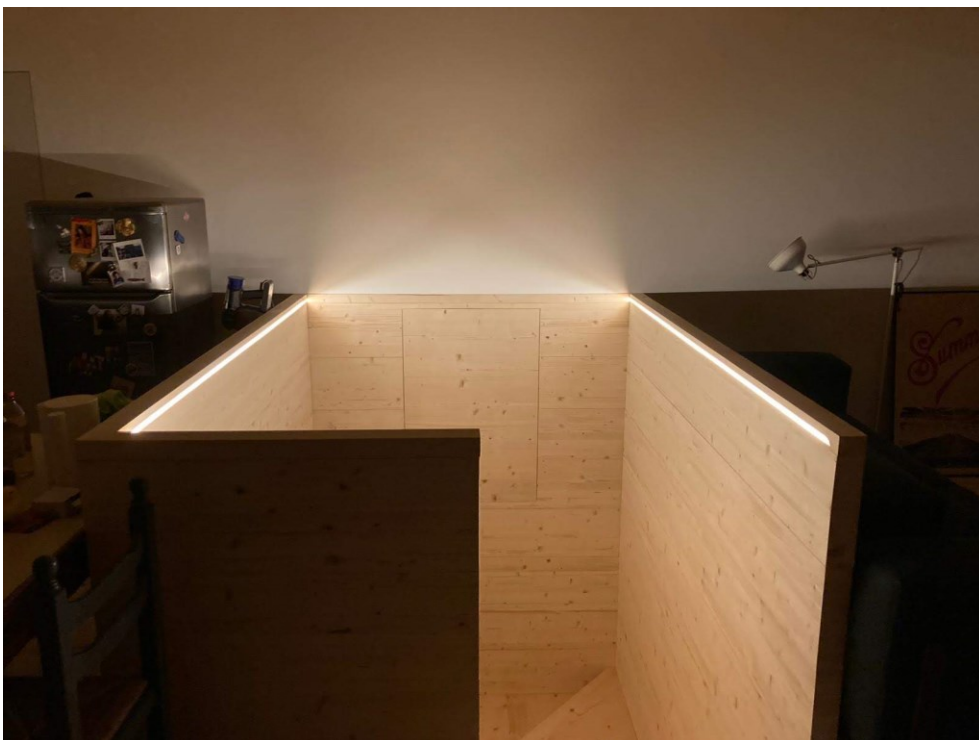
Figure 41: Un esempio di installazione di Next-Light sul bordo superiore della scala interna – Valdagno (Provincia di Vicenza).
