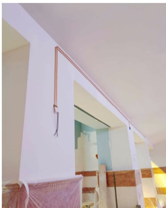
Figura 24: Realizzazione di un impianto di illuminazione mediante Nastro elettrico NM3BT15 in una chiesa di Andria, in Puglia
